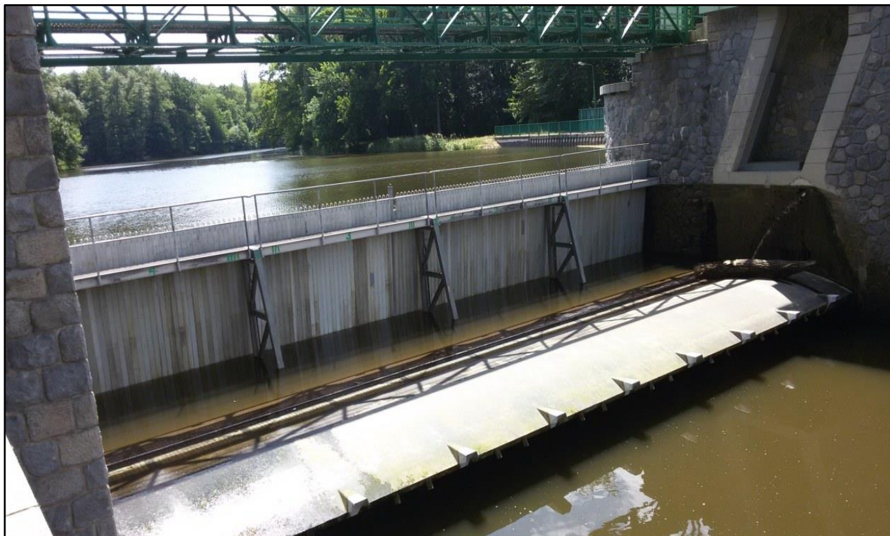
Foto č. 4 – Provizorní hrazení z horní vody po montáži (pohled z podjezí VD)
